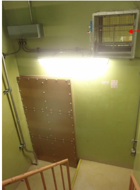
図4 想定した溢水経路以外に他区画へ流出する可能性のある開口部の例 (廃棄物処理建物1階)
