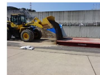
第6図 段差復旧状況
