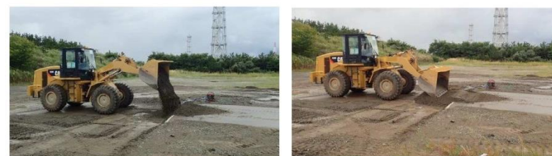
段差復旧状況①
