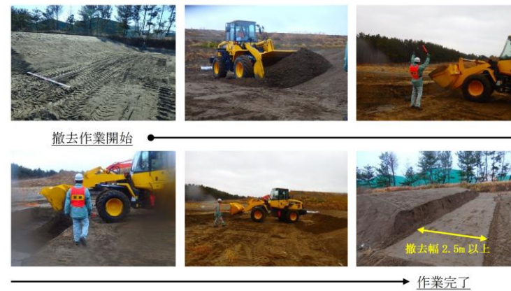
第8図 土砂撤去検証の写真
