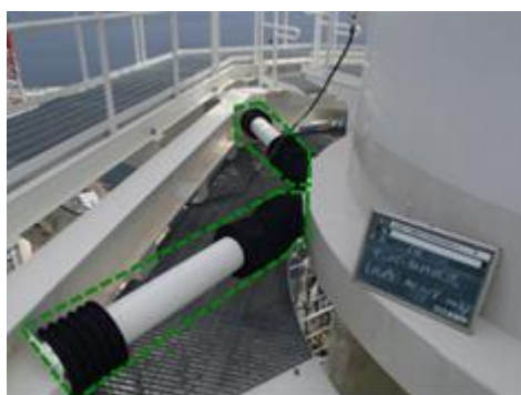
第1-2-1添図 島根2号炉の排気筒に設置した単軸粘性ダンパの外観及び構造
