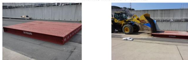
第6図 段差復旧状況
