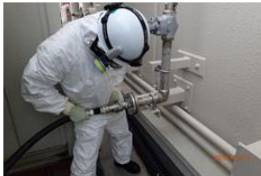
ホース接続作業
