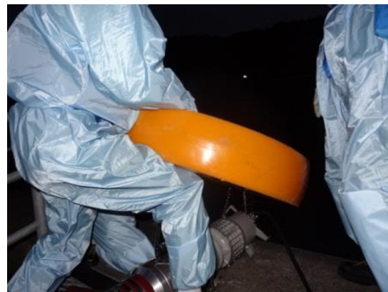
水中ポンプ設置準備（夜間）
