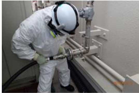
ホース接続作業
