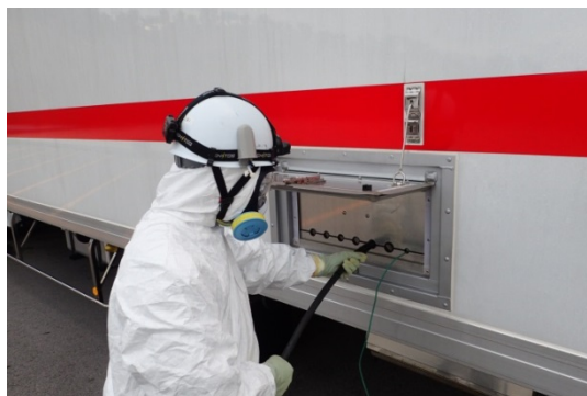
ケーブル接続作業
