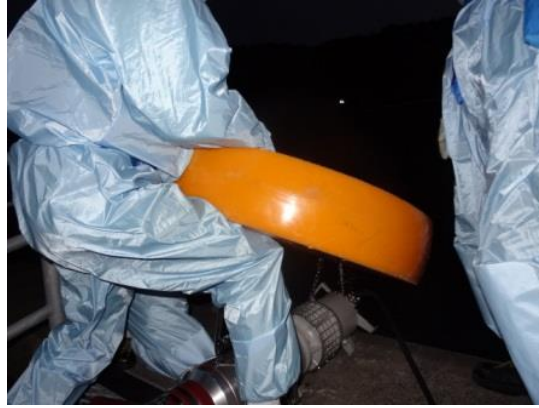
水中ポンプ設置準備（夜間）
