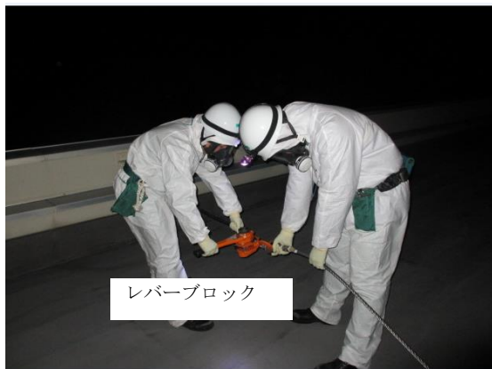
ワイヤー，レバーブロック接続作業
