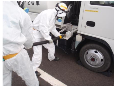
タンクローリへの燃料ホース接続
