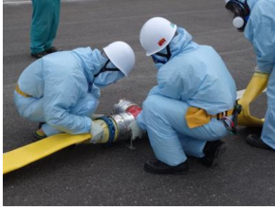
ホース接続作業（昼間）
