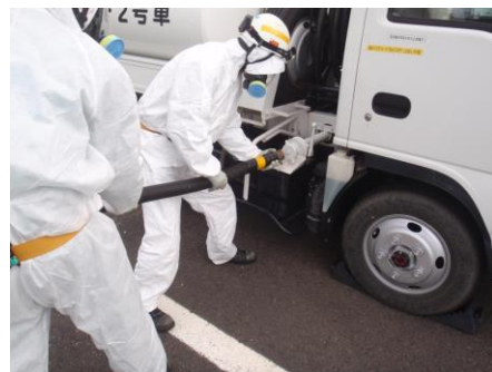
タンクローリへのホース接続
