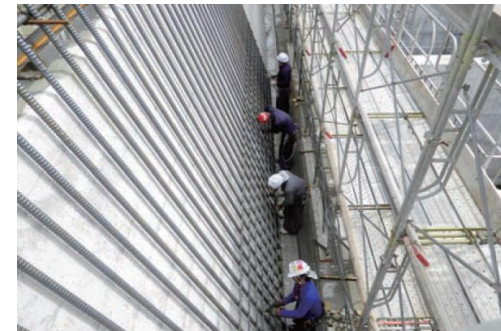
陸側鉄筋組立状況
