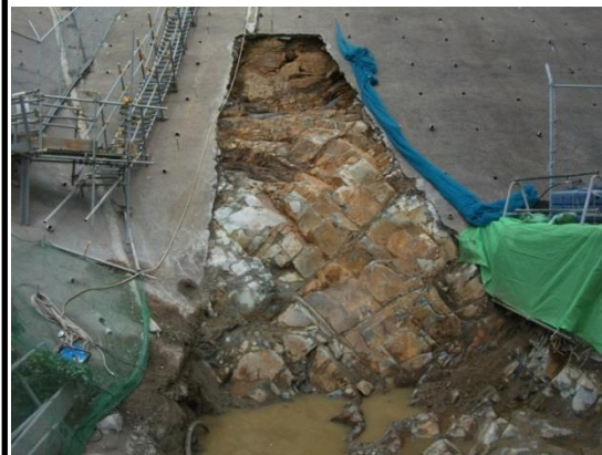
防波壁東端部 岩盤露出状況
