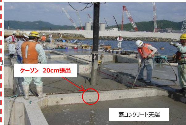
蓋コンクリート打設状況
