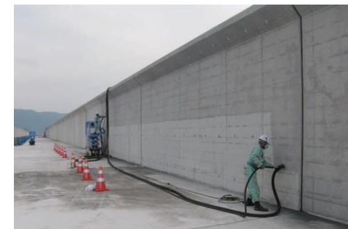
目荒らし施工状況
