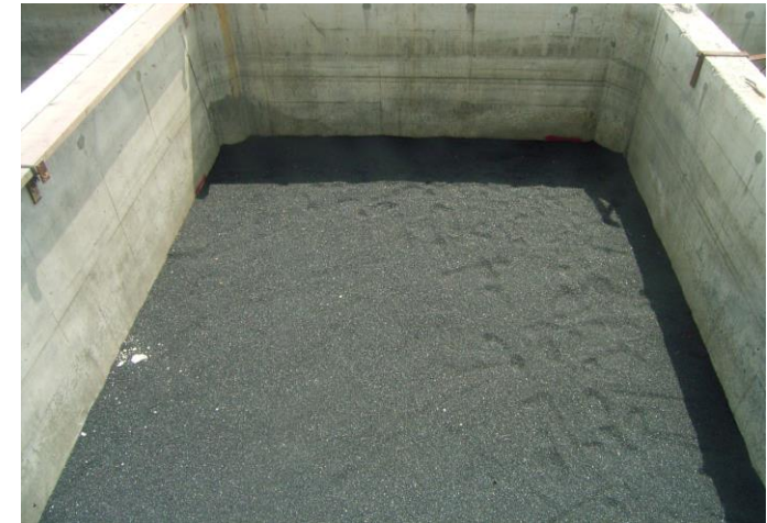
中詰材（銅水砕スラグ）充填状況 （蓋コンクリート打設前）
