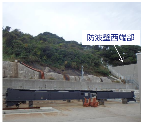
防波壁西端部 状況写真
