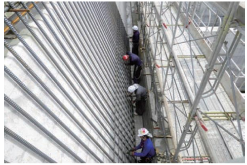
陸側鉄筋組立状況
