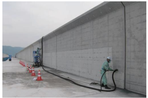
目荒らし施工状況
