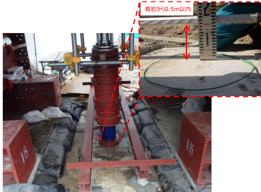
試験状況（全景）
