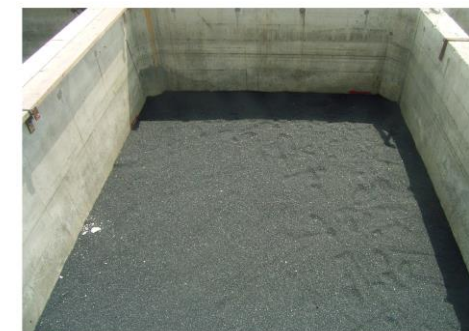
第 1-93 図 防波壁 (波返重力擁壁) ケーソン中詰材充填状況
