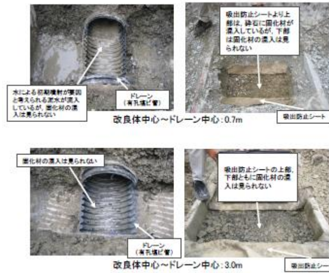
第18 図 地盤改良後のドレーン及びフィルター材状況
