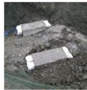
ドレーン(U字溝)設置状況
