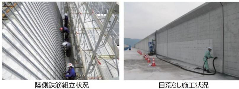
第3図 施工状況写真
