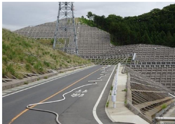
写真2 ホース展開状況
