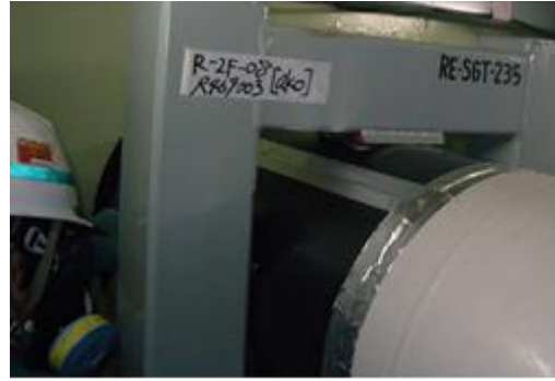
② ゴムシート貼付
