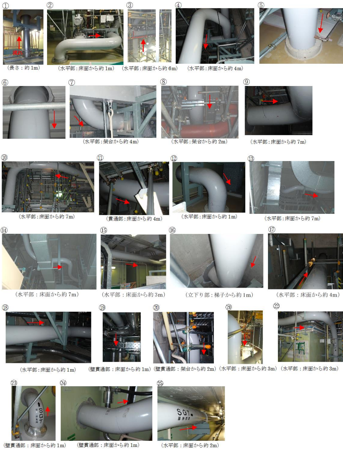
別紙図 1-9-1-2 配管敷設状況
