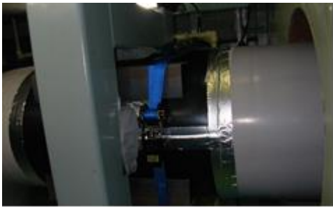
③ 修復完了
