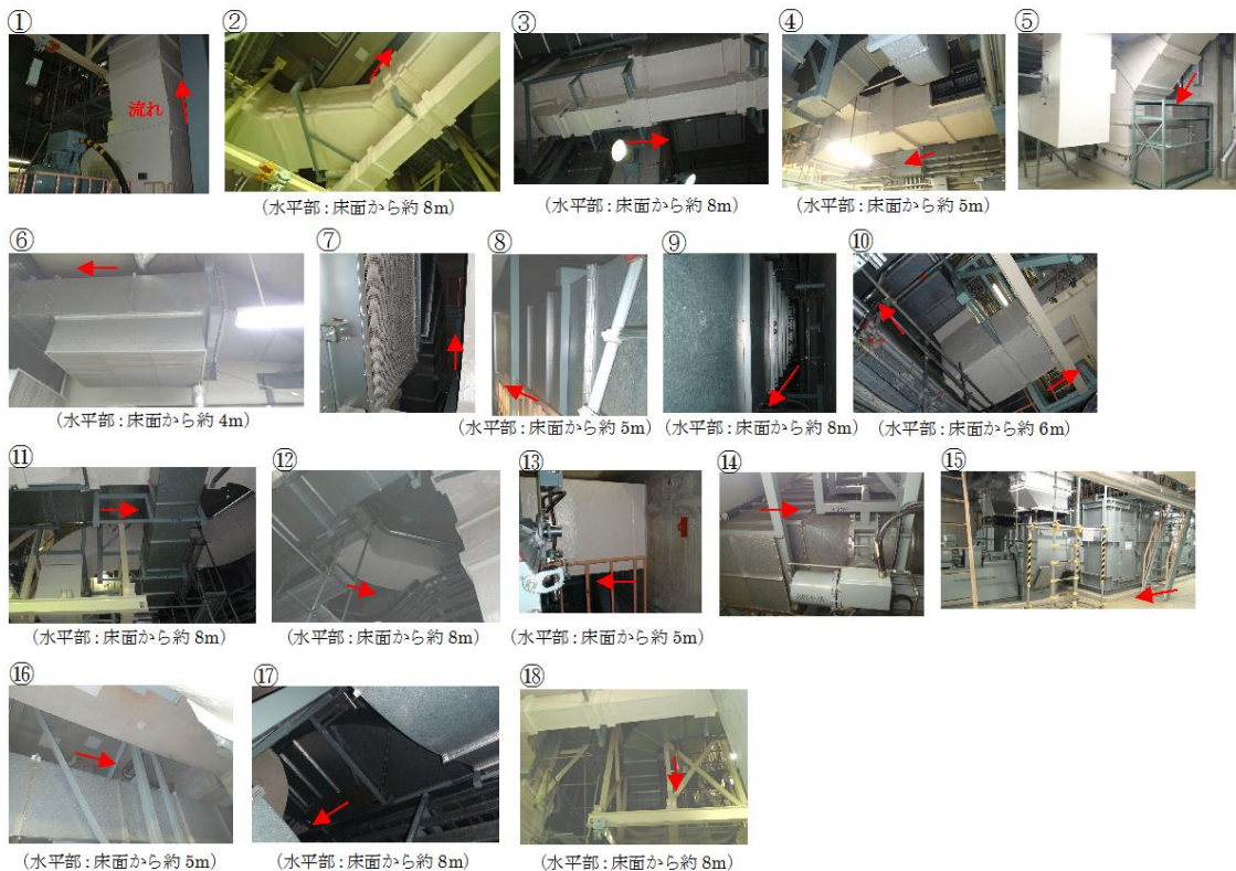
別紙図 1-9-2-2 ダクト敷設状況
