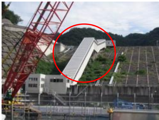
33 エスカレータガラス窓（4.4m盤）
