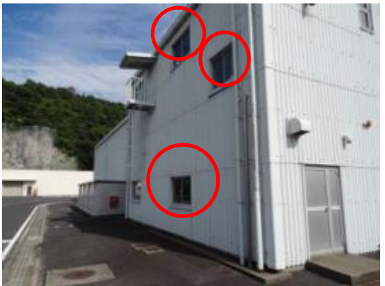
64 2号倉庫ガラス窓
