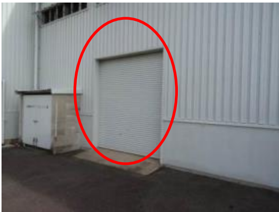
55 補助ボイラー室北側シャッター (2)
