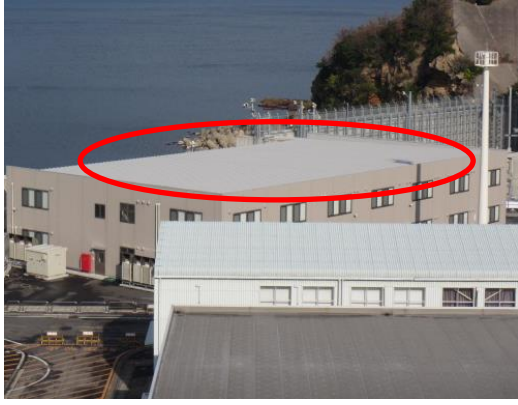
177 4号館管理事務所
