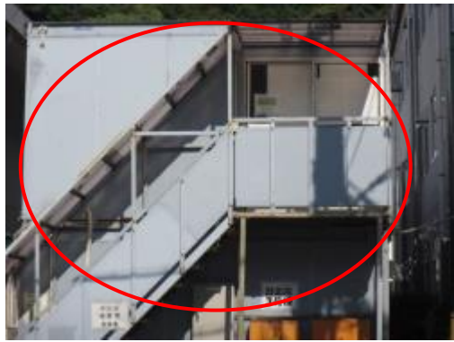
42 協力会社事務所南側ガラス窓 (4 4 m 盤)
