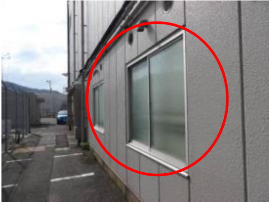
68 サイトパンカ建物ガラス窓（1）
