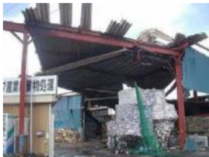
折板の損傷
