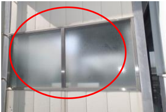
94 1号開閉所ガラス窓
