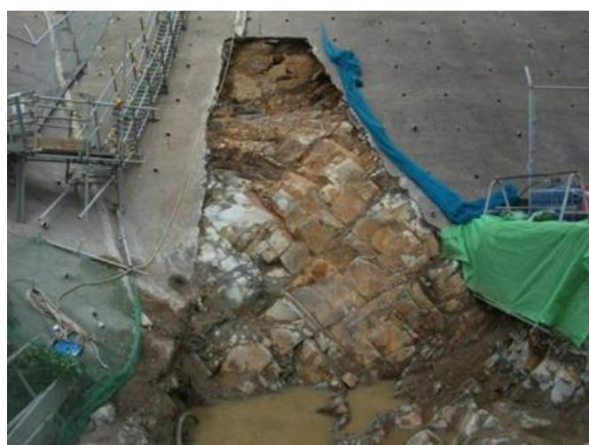
図 2-19 防波壁東端部 岩盤露出状況
