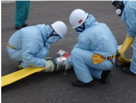
第3図 放射線防護具類を着用した状態での大量送水車設置作業
