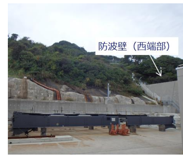
図2-21 防波壁西端部 状況写真
