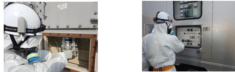
第4 図 放射線防護具類を着用した状態での高圧発電機車のケーブル敷設作業
