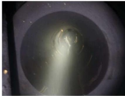
写真A ドレーン(有孔ヒューム管φ800mm)
