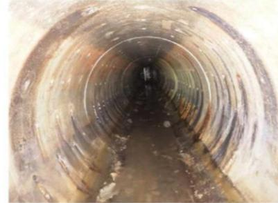
写真A ドレーン(有孔ヒューム管φ1,050mm)
