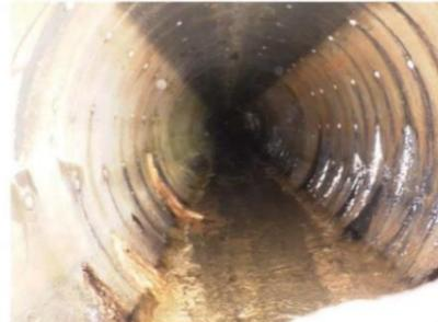
写真B ドレーン(有孔ヒューム管φ1,050mm)
