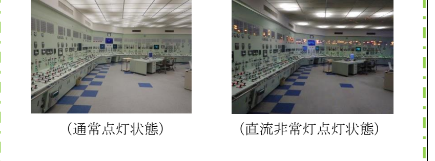
図 2.5-4 直流非常灯照明下での中央制御室のイメージ (シミュレータの点灯例)
