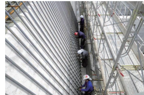
陸側鉄筋組立状況
