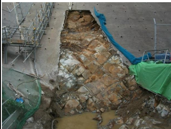
防波壁東端部 岩盤露出状況
