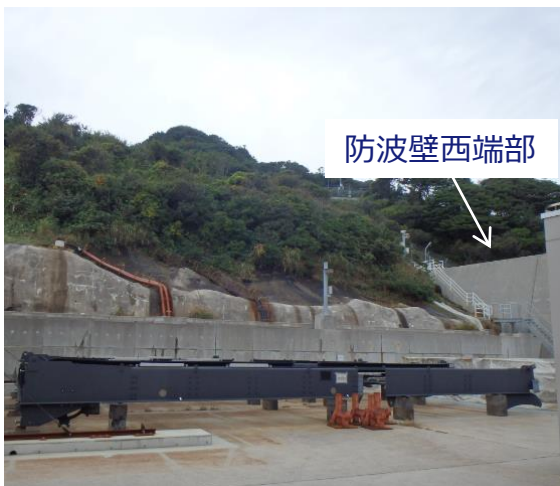
防波壁西端部 状況写真
