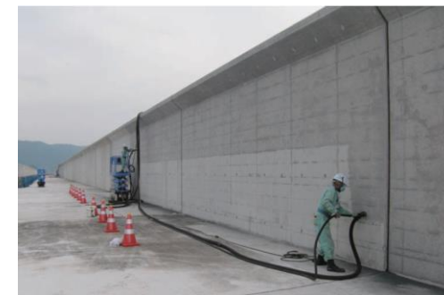
目荒らし施工状況
