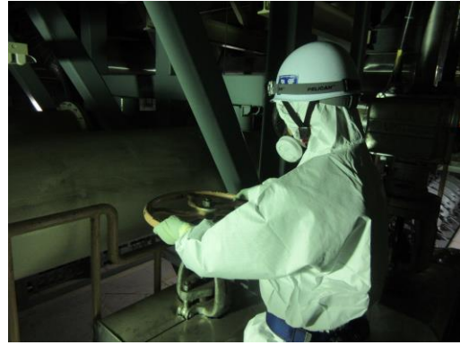
冷却水確保（系統構成）
