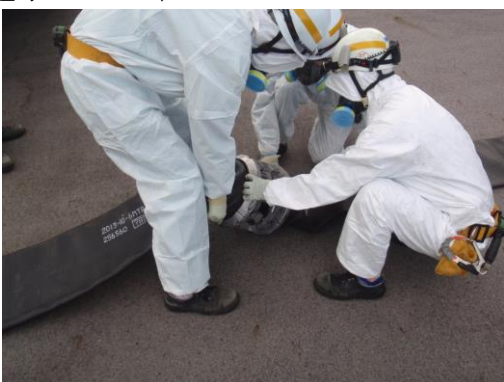
ホース接続作業
