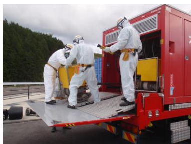
水中ポンプ設置準備
