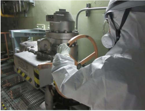
冷却水確保（系統構成）
