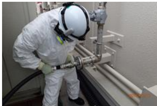
ホース接続作業
