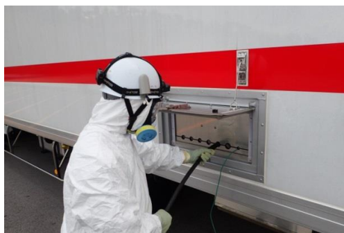
ケーブル接続作業
