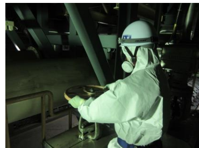
冷却水確保（系統構成）
