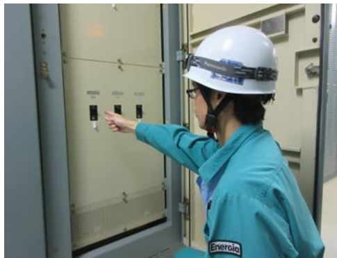
電源切替操作
