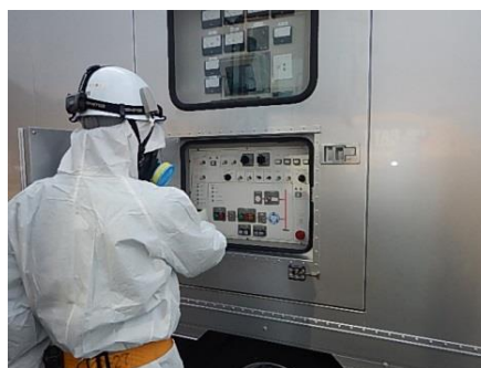
高圧発電機車での作業
