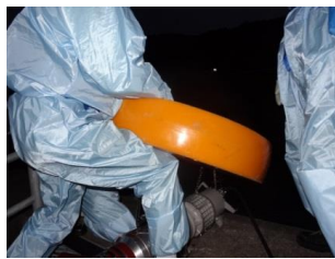
水中ポンプ設置準備（夜間）
