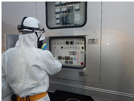
高圧発電機車での作業
