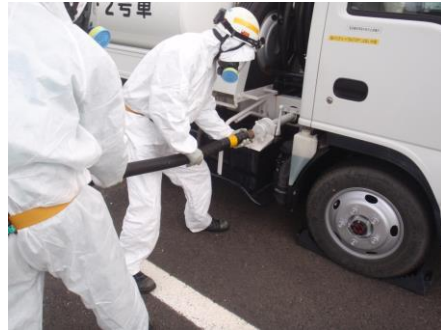
タンクローリへの燃料ホース接続
