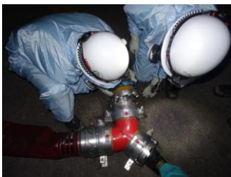
ホース接続作業（夜間）
