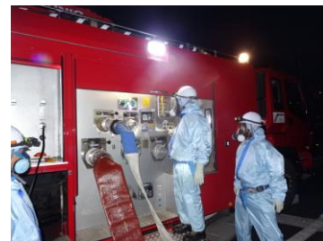
ポンプ起動操作（夜間）
