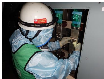
ボルトリンク接続作業
