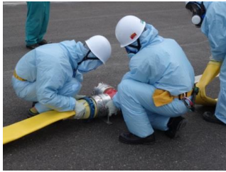
ホース接続作業（昼間）
