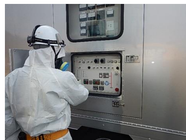
高圧発電機車での作業
