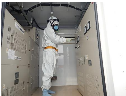
直流給電車での作業
