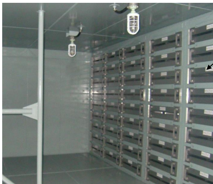
フィルタ（非常用）取付状態
