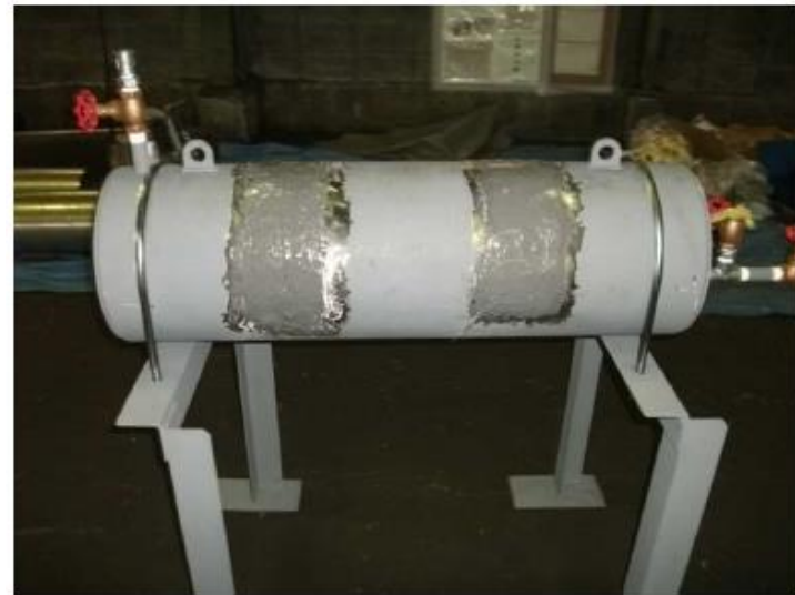
図 2. 1. 2-6 ベロメタル補修後の耐圧試験
