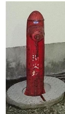
第2-2図 不凍消火栓外観
