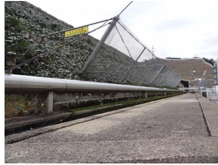
第 1 -32 図 屋外消火配管への保温材の設置状況
