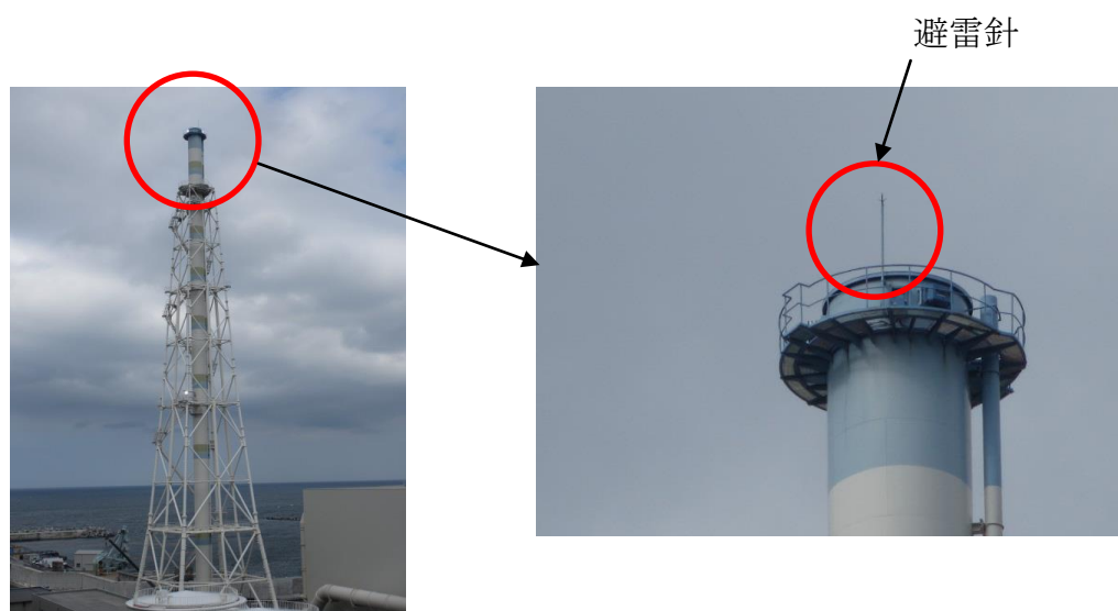
第1-15図 避雷設備の設置例（排気筒）
