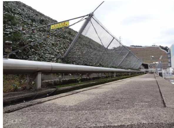
屋外消火配管の地上化
