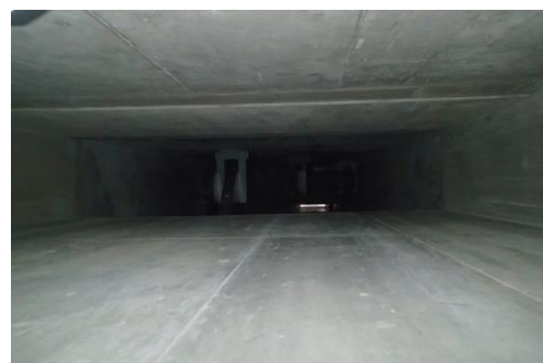
B-給気消音器フィルタ室内
