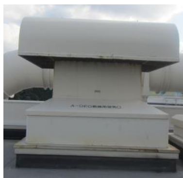
第 3-1 図 ディーゼル発電機吸気口
