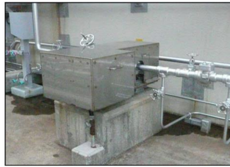
図 5-2 燃料移送ポンプ外形写真
