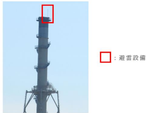
第1-16図 排気筒の避雷設備
