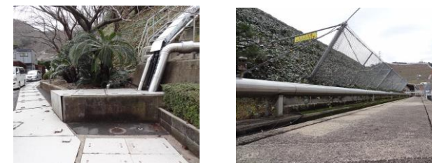
第 1 -32 図 屋外消火配管への保温材の設置状況
