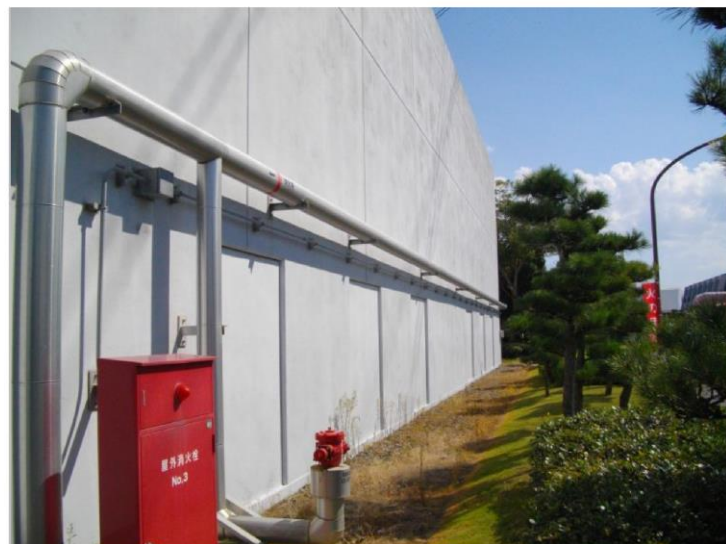
第1-36図 屋外消火配管への保温材設置状況
