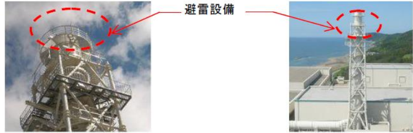
第 1-16 図：避雷設備の設置例（主排気筒）
