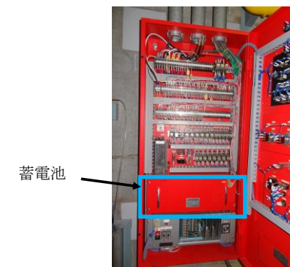
第1-28図 消火設備の電源確保の概要
