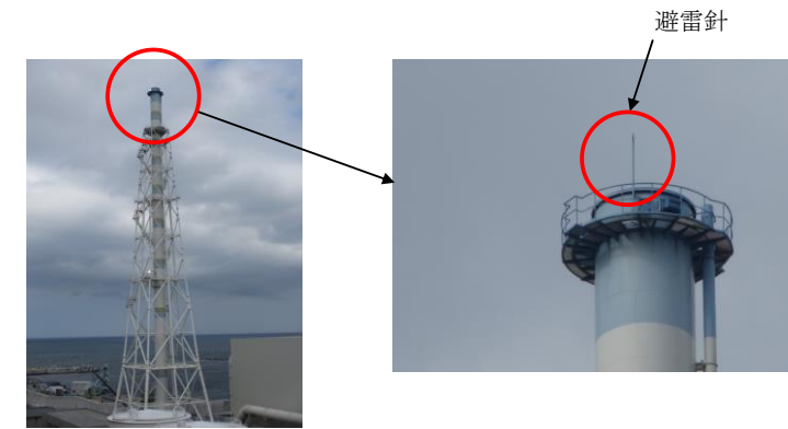
第 1-15図 避雷設備の設置例（排気筒）
