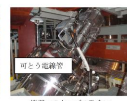
機器へのケーブル取合い (主蒸気内側隔離弁との取合い)
