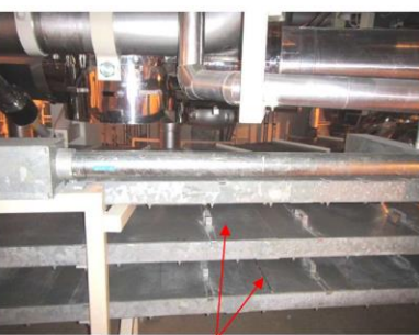
機器へのケーブル取合い状況 (格納容器貫通部とケーブルトレイ・電線管との取合い)
