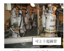
機器へのケーブル取合い (主蒸気速がし安全弁との取合い)
