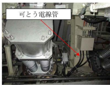
機器へのケーブル取合状況 (主蒸気内側隔離弁との取合)
