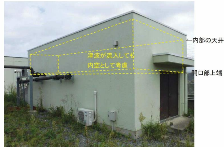
図2.5-26 開口部が破損して建物内部に津波が流入しても内空として考慮する空間の例(2号炉放流管真空ポンプ室(No.5)の例)
