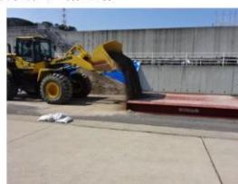
第6図 段差復旧状況
