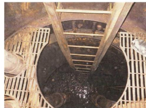
写真C 揚水井戸⑦(下段部) 2017/3/16撮影
