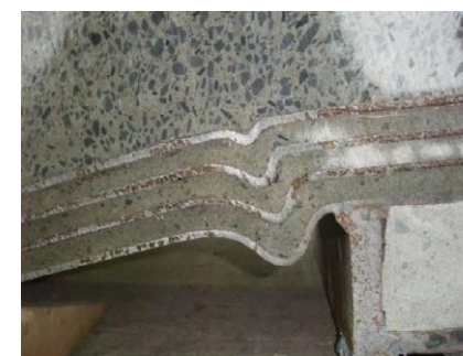
圧縮縁はらみ出し状況
