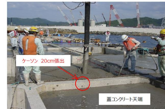
蓋コンクリート打設状況
