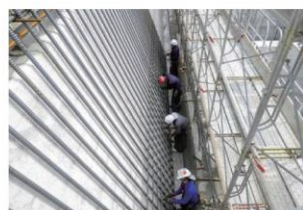
陸側鉄筋組立状況
