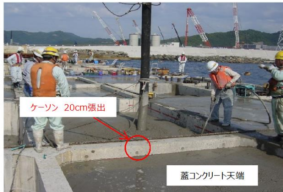
蓋コンクリート打設状況
