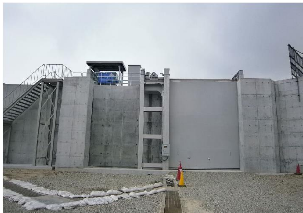
第 1-44 図 防波壁通路防波扉（1，2号炉北側）④ 設置状況
