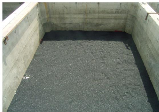
中詰材（銅水砕スラグ）充填状況 （蓋コンクリート打設前）
