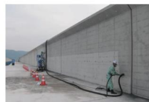
目荒らし施工状況
