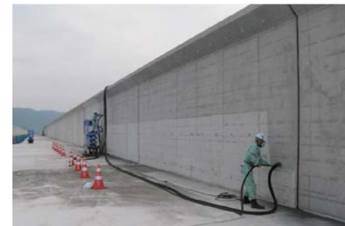
目荒らし施工状況
