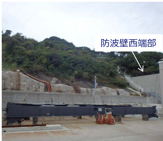
防波壁西端部 状況写真
