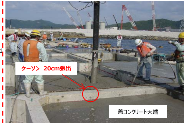
蓋コンクリート打設状況
