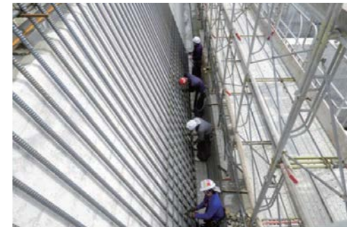
陸側鉄筋組立状況
