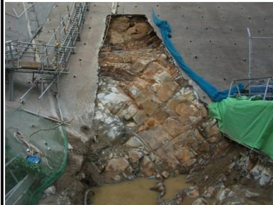
防波壁東端部 岩盤露出状況
