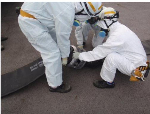
ホース接続作業
