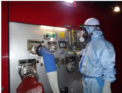
ポンプ起動操作（夜間）
