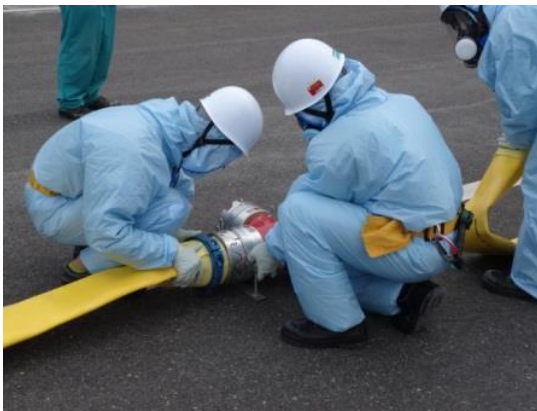
ホース接続作業（昼間）
