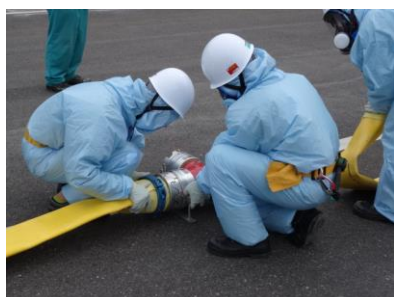
ホース接続作業（昼間）
