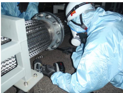
ホース接続作業
