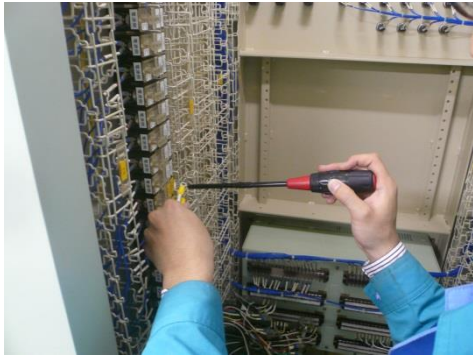
自動減圧継電器盤へ接続
