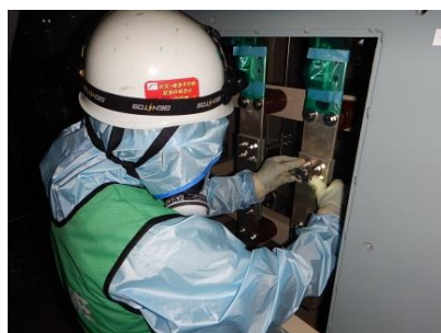
ボルトリンク接続作業
