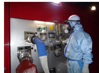
ポンプ起動操作（夜間）
