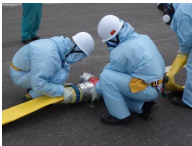
ホース接続作業（昼間）
