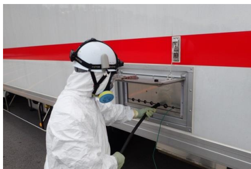
ケーブル接続作業
