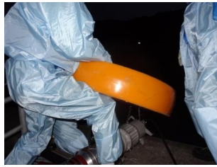
水中ポンプ設置準備（夜間）
