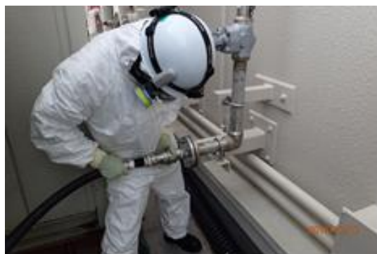
ホース接続作業
