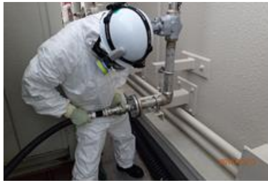
ホース接続作業
