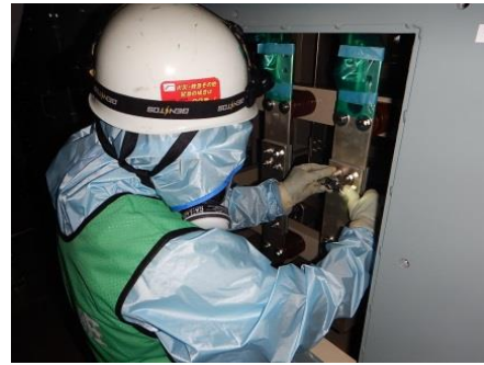
ボルトリンク接続作業
