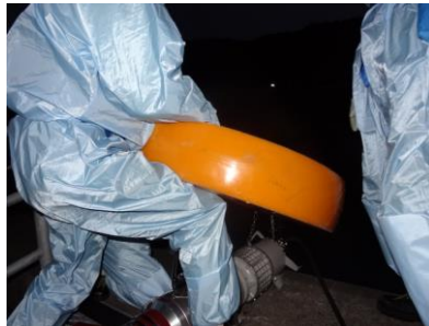
水中ポンプ設置準備（夜間）
