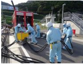
水中ポンプ設置準備（昼間）
