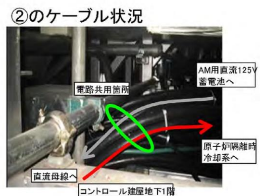
図 57-10-6 ケーブルトレイ共用電路 (7号炉)
