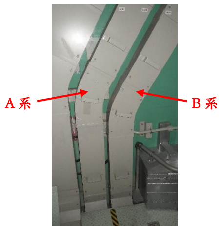
写真② (原子炉建家1階から地階へ)
