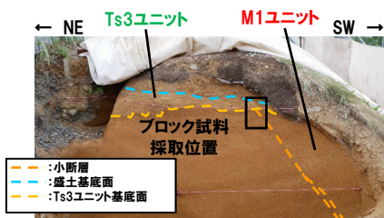
開削調査箇所(南側)南側壁面 小断層上端付近 拡大写真
