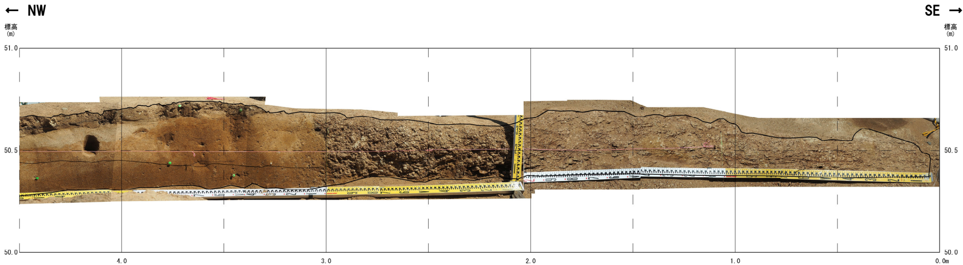
開削調査箇所(南側)側溝設置跡(山側壁面) 写真(範囲D)
