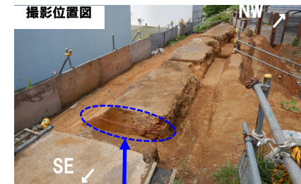
横断掘削箇所③
