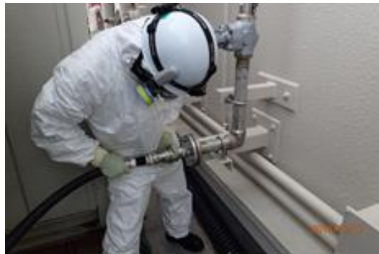
ホース接続作業
