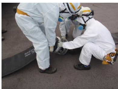
ホース接続作業
