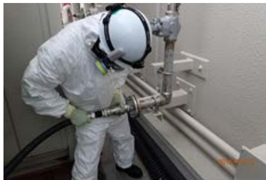
ホース接続作業
