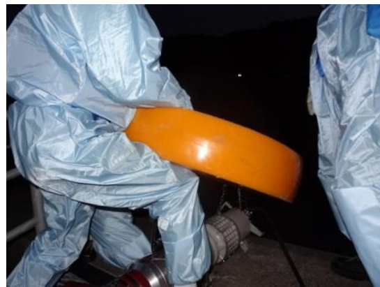
水中ポンプ設置準備（夜間）
