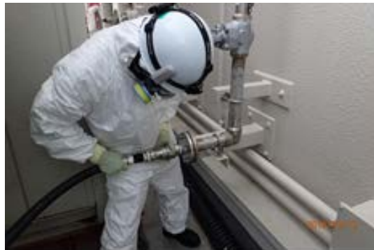
ホース接続作業
