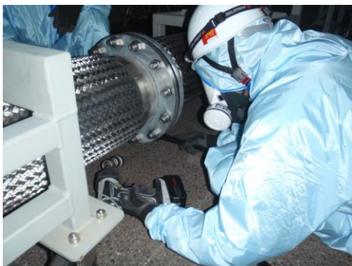
ホース接続作業
