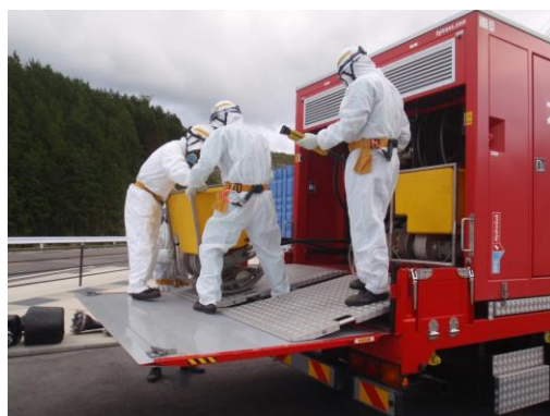
水中ポンプ設置準備
