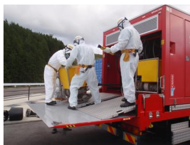
水中ポンプ設置準備
