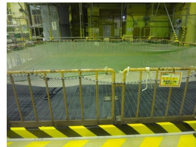
図2 大物搬入口外観
