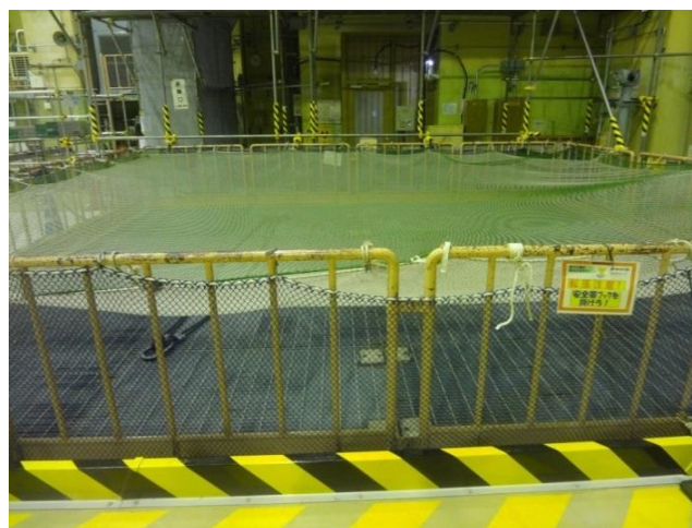
図 2 大物搬入口外観
