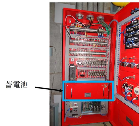
第41-1-24図 消火設備の電源確保の概要
