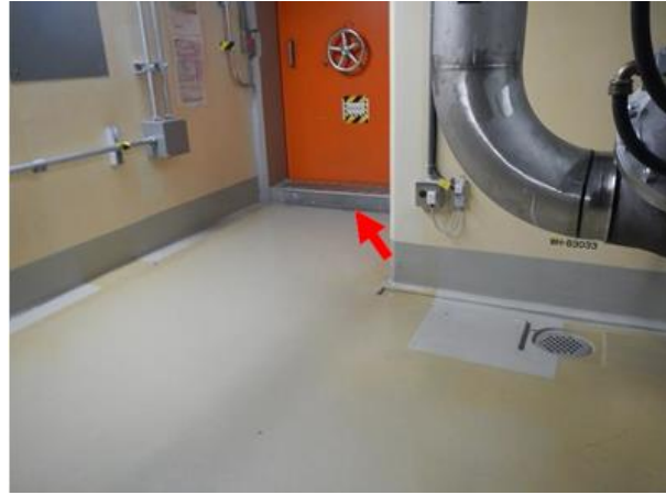
第 41-1-2 図：堰による拡大防止対策概要図
