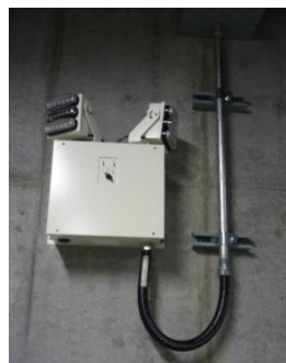
消火用非常照明（壁掛け型）の設置例
