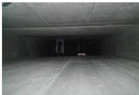
B－給気消音器フィルタ室内
