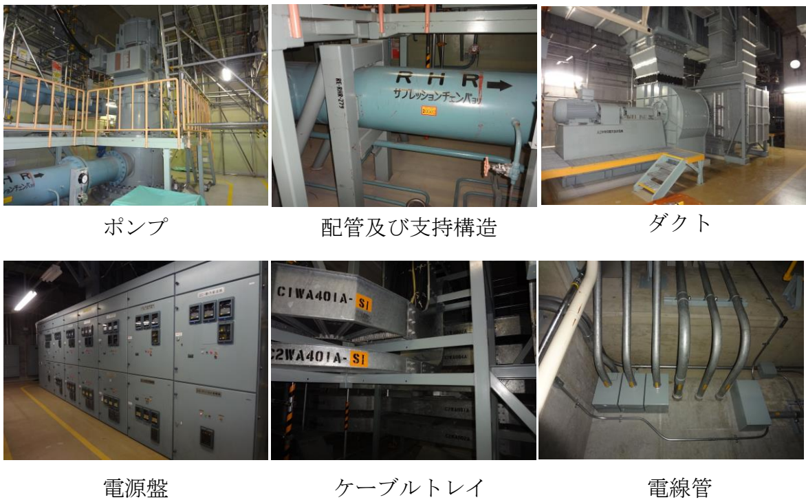
第41-1-9図 主要な構造材に対する不燃性材料の使用状況
