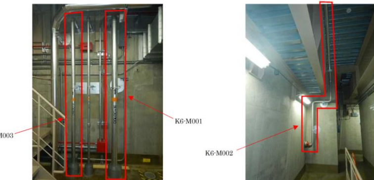
第1-4図 現場状況写真 (配管敷設状況)
