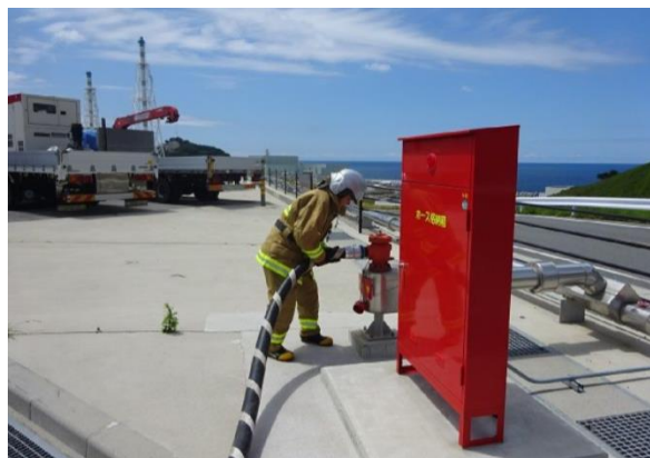
写真1 消火栓接続
