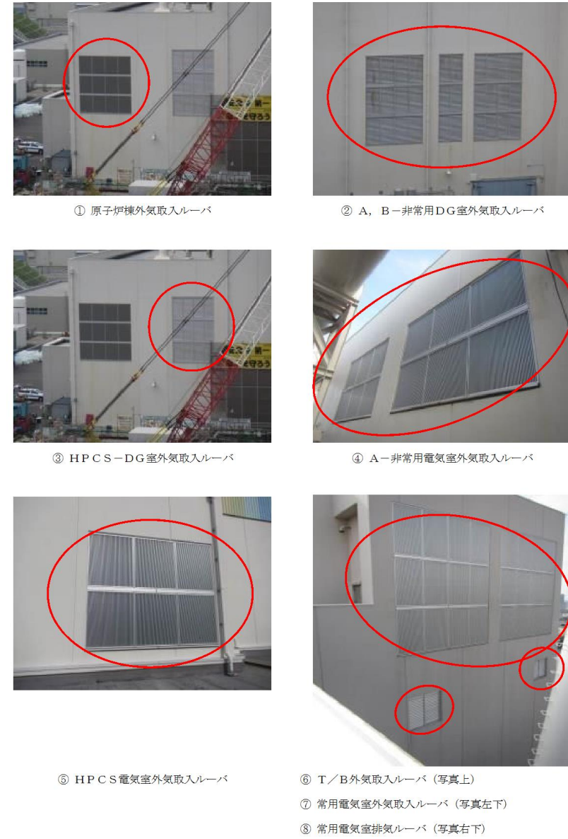
図3-1 外気取入ルーバの外観写真 (1 / 2)
